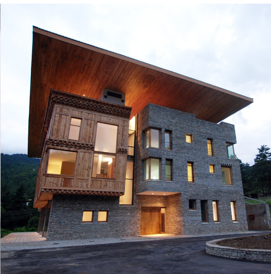
Fassade Ost mit Eingangsbereich
