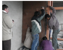
2: Dieter Gausterer zeigt die Applikation von Dichtbändern
